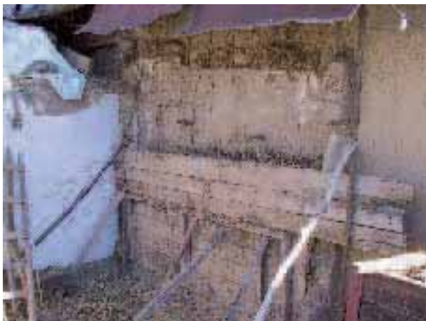
Lors d'un atelier qui s'est déroulé au Kirghizistan, avec la participation d'une vingtaine de personnes issues de plusieurs pays de l'Asie centrale, une maison a été isolée à l'aide de matériaux disponibles sur place (Projet de la Direction Suisse pour le Développement et la Coopération).
